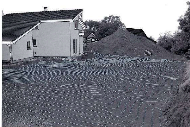
Fig. 4.1 – Mise en place d'un circuit de captage horizontal
