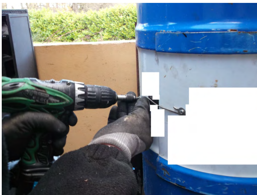
Pose du crochet (*2) pour la fermeture de la porte
