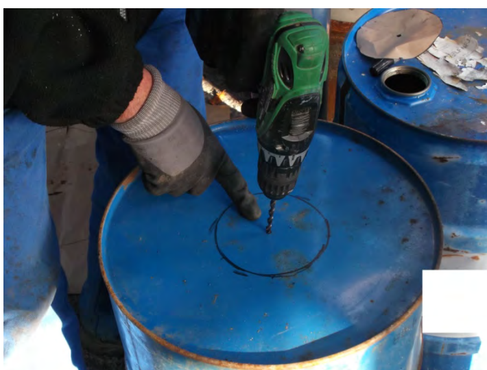
Le perçage permet le passage de la lame de la scie sauteuse
