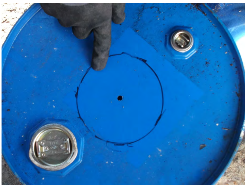
Le perçage permet le passage de la lame de la scie sauteuse
