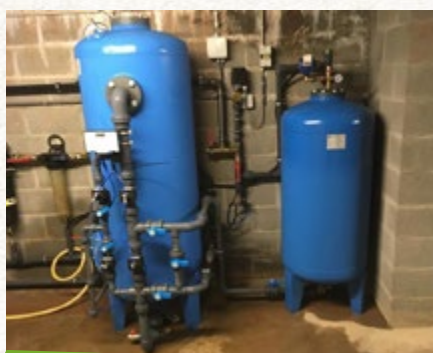
Déferriseur (filtre à sable) et groupe hydrophore installés par l'entreprise Seliac
