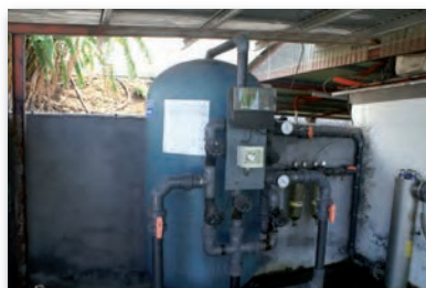
Système de filtration de l'eau : filtre à sable, filtres à chaussette, lampes UV.
