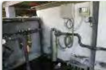
Désinfection de l'eau par lampes à ultra violet.
