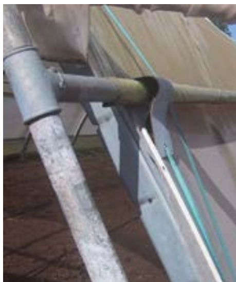
▲ Fixation latérale d'un abri anti-cyclone à Mayotte.
