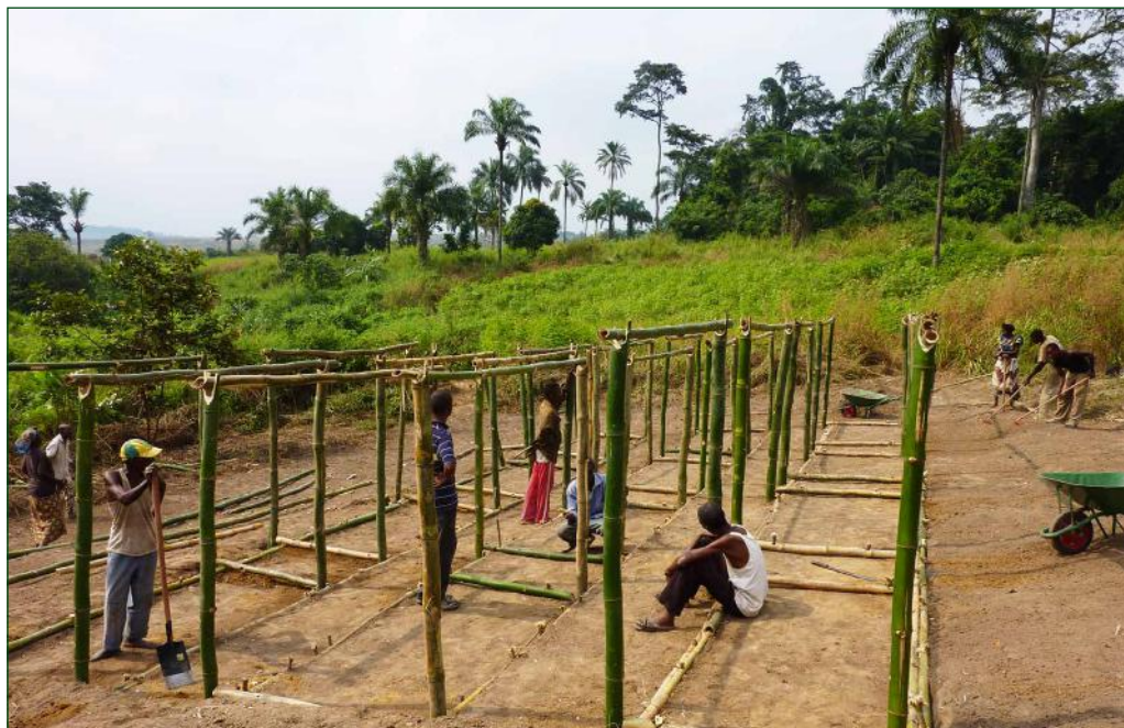
Photo 11. Construction d'une pépinière communautaire en bambou sur sol préalablement terrassé. © K.D.
