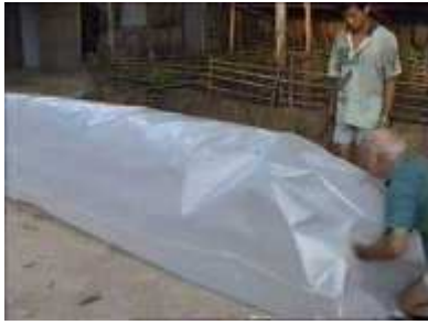
Photo 29. Le digesteur est rempli d'air
