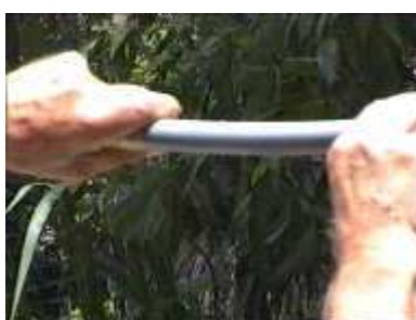
Photo 77. Faire un trou dans le conduit en PVC, laisser couler l'eau, reboucher avec une bande de scotch (pb 6-2)
