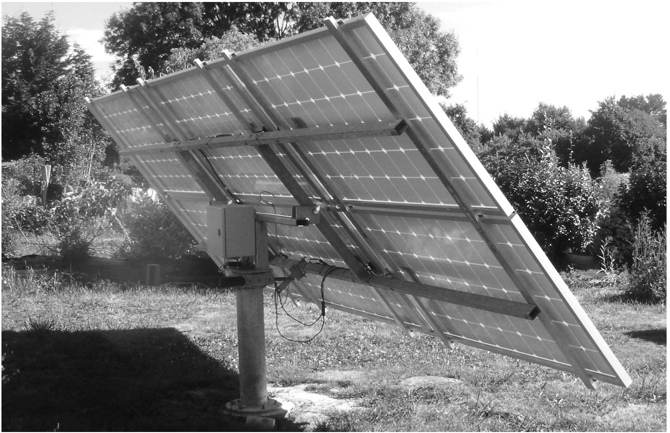
Installation PV de 1500 Wc sur un « tracker » qui a coûté assez cher pour le gain espéré.
