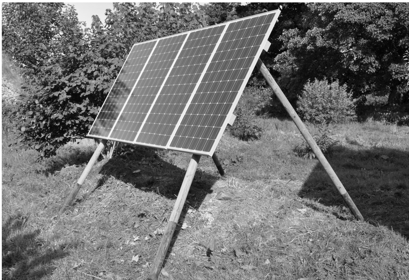
Le même portique avec les PV de 600 Wc, l'orientation qui n'est pas modifiable est idéale pour l'hiver.
