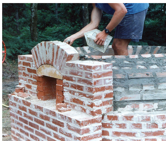
Finition des joints
