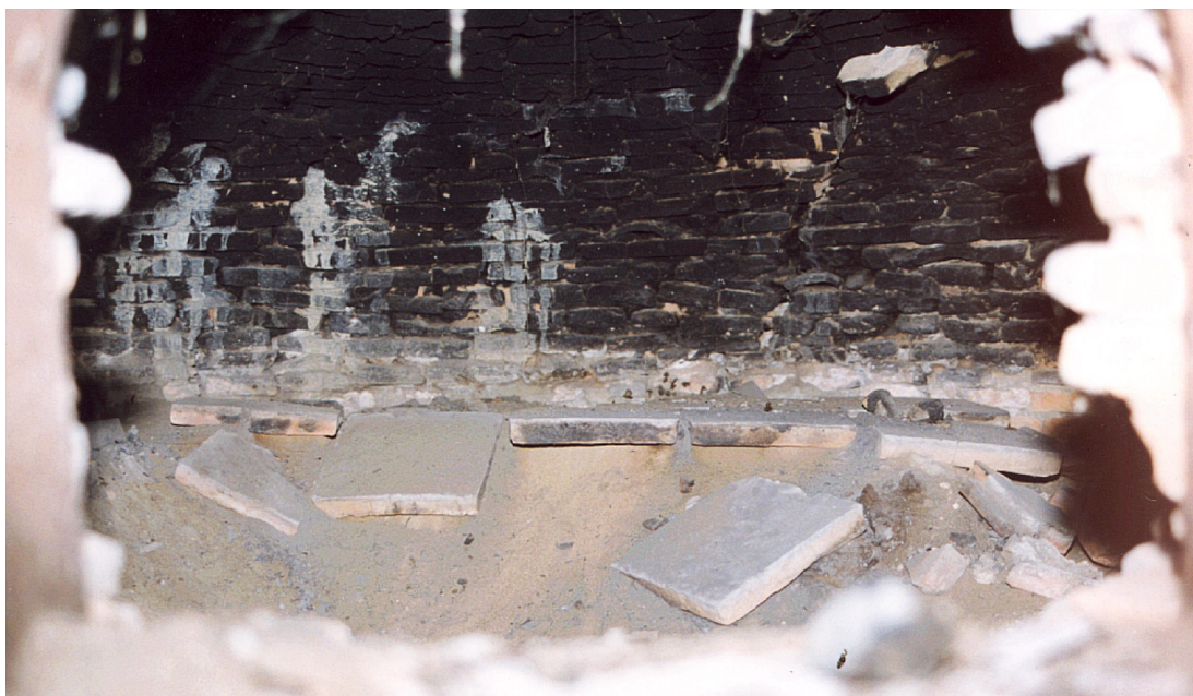
Sole effondrée dans un four à l'abandon
