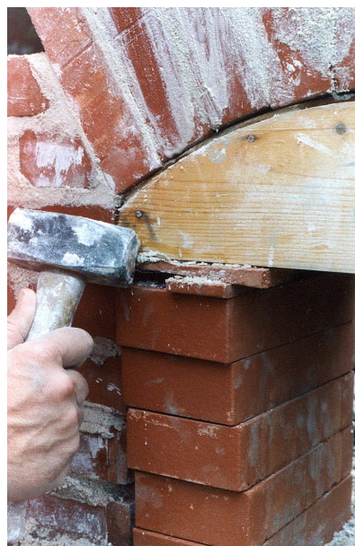
Décoffrage par dégagement des cales d'appui du gabarit
