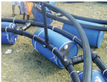
Système flottant constitué de fûts vides en plastique.
